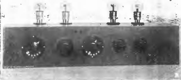
APPARECCHI RICEVENTI a 3 e 4 valvole costruiti secondo le nuove norme dell'Istituto Superiore P.T.T.
